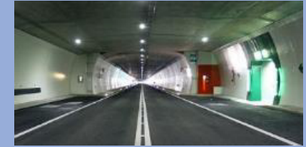
Tunnel und Geotechnik
